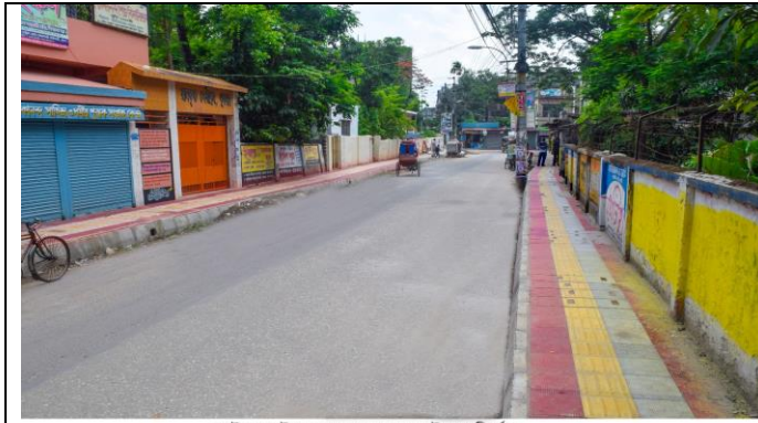
সাউথ সেক্ট্রাল রোডে ড্রেন সহ ফুটপাথ নির্মাণ
