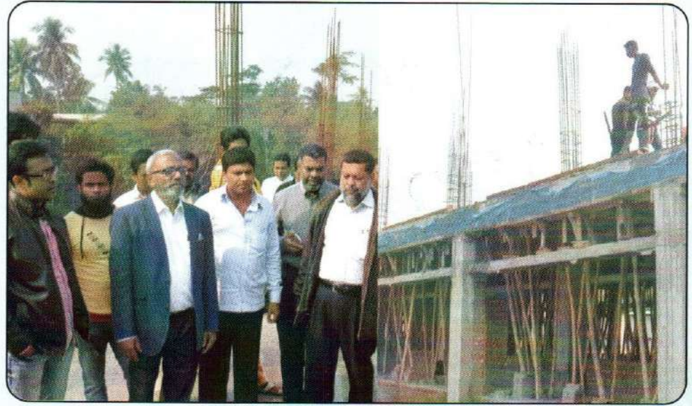
দৌলতপুর কলেজ নির্মাণ কাজ পরিদর্শন কেসিসি মেয়র মনিরুজ্জামান
